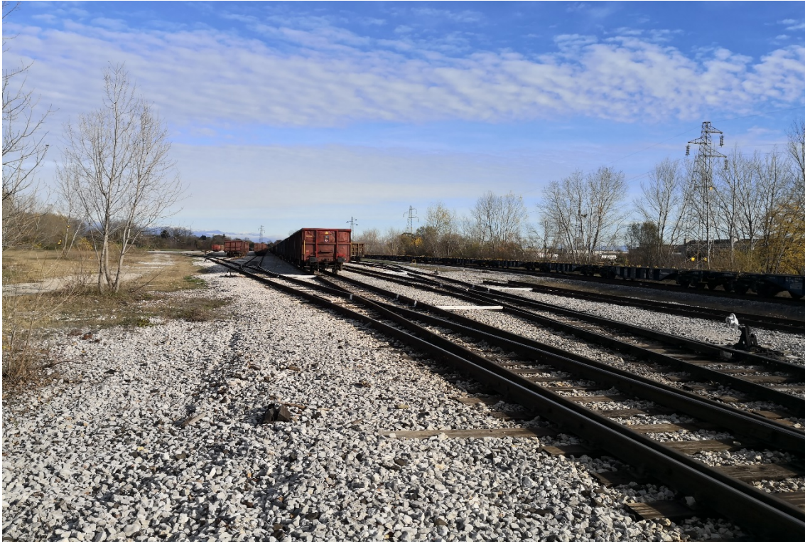
Dettaglio scalo ferroviario ZIU
