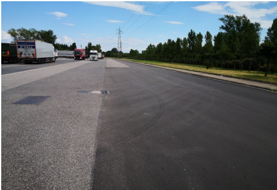
Interventi di sistemazione in via ferriere in ZIAF
