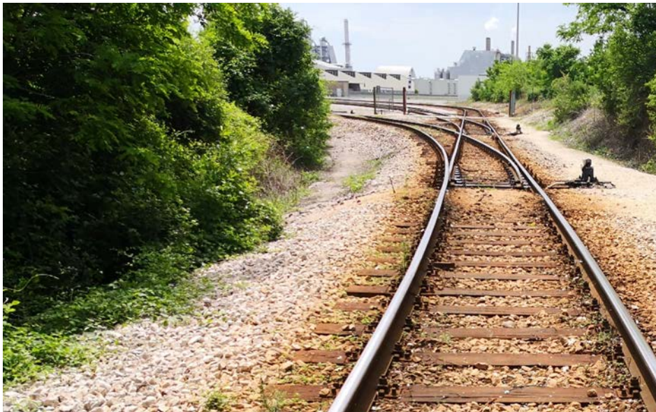
Alto Friuli: dorsale di accesso allo scalo ferroviario
